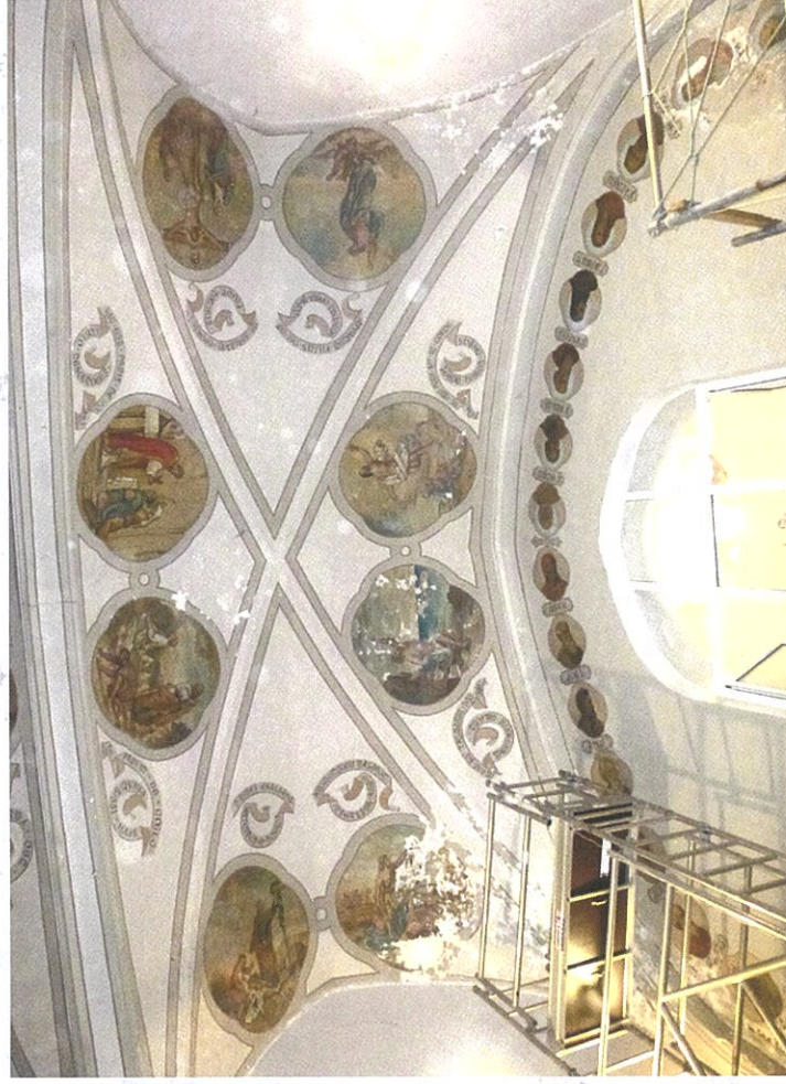
Restauration Eglise St Blaise XIX e «Arre»
